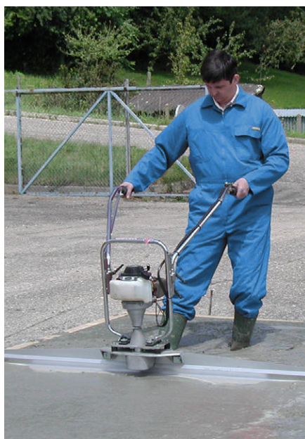
Плавающая виброрейка BV30 с профилями
